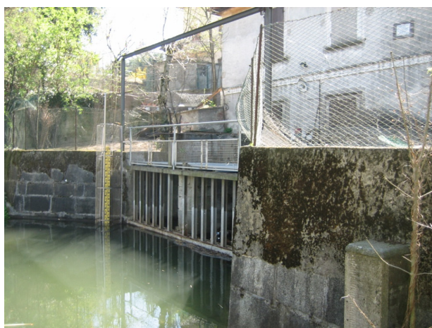
Fig. 10 Edificio del Cavo Diotti
