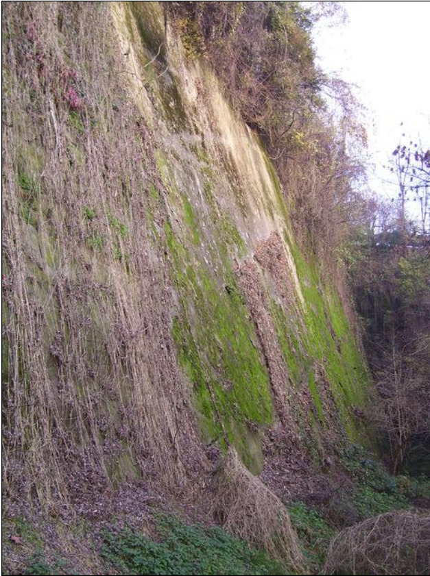
La parete della cava
