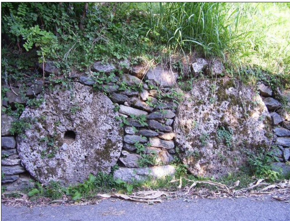
Esempio di macine integrate nei muretti in Via Privata Crivelli a Inverigo
