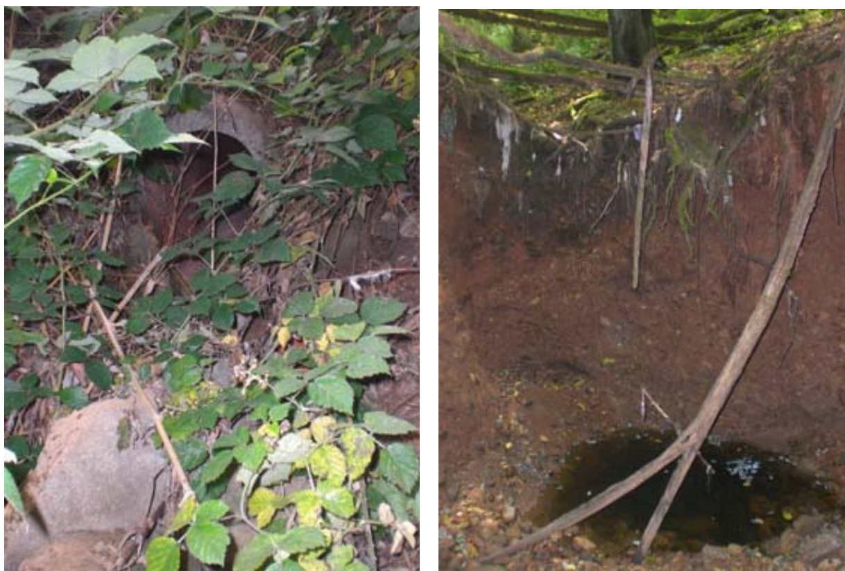
FIGURA 2.5 TUBAZIONE PRESENTE IN CORRISPONDENZA DELL'ORIGINE DELL'IMPLUVIO (A SINISTRA); PRESENZA DI UNO SCOLMATORE (A DESTRA)(ARCHIVIO CSBA).
