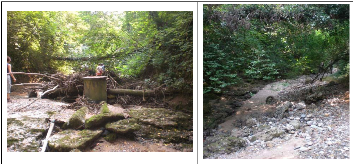
FIGURA 2.10 MATERIALE TRASPORTATO DURANTE LE PIENE DAL TORRENTE ED ACCUMULATO A RIDOSSO DI UNA COLONNA D'ISPEZIONE DEL COLLETTORE FOGNARIO (A SINISTRA). TRATTO IN ASCIUTTA DEL TORRENTE (A DESTRA) (ARCHIVIO CSBA, 2009).
