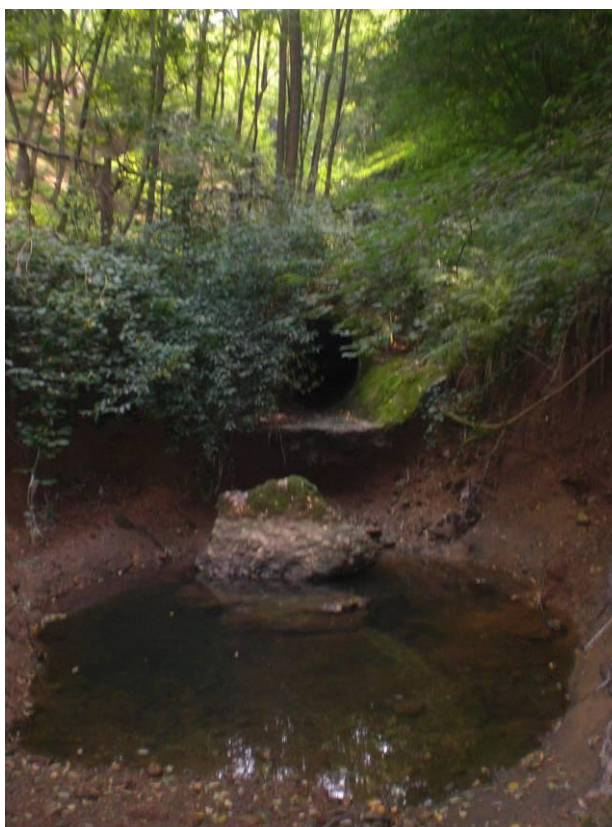
FIGURA 2.17. VALLETTO IN SINISTRA IDROGRAFICA CON SCOLMATORE (SPONDA OPPOSTA DI TZ 0101) (FOTO ARCHIVIO CSBA).
